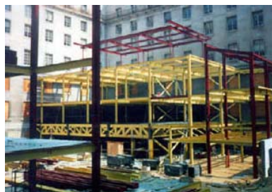
Figura 5. Construcción de acero estructural.
