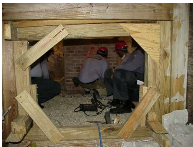
Figura 12. Apuntalamiento ventana/puerta completo, con acceso.
