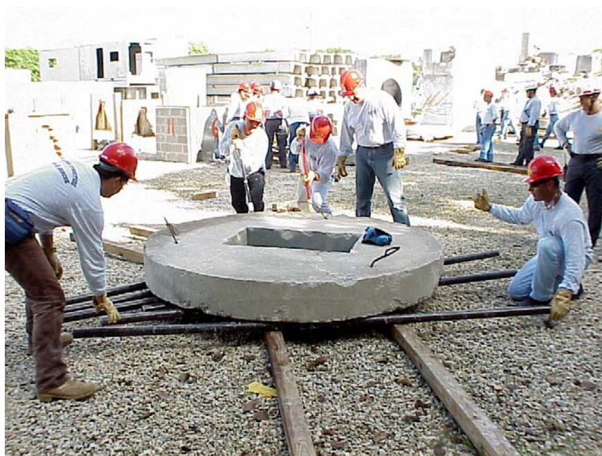
Figura 10. Rodamiento de una placa con tubos de acero.
