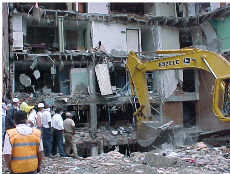
Figura 4. Remoción de escombros a máquina.
