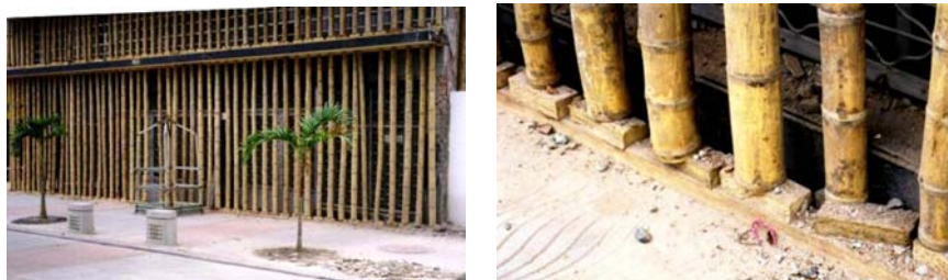
Figura 6. Apuntalamiento improvisado de bambú.
