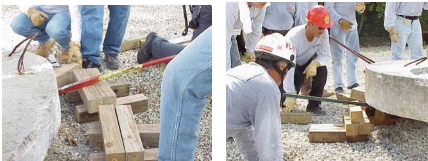
Figura 9. Levantamiento de un objeto pesado utilizando entarimado.
