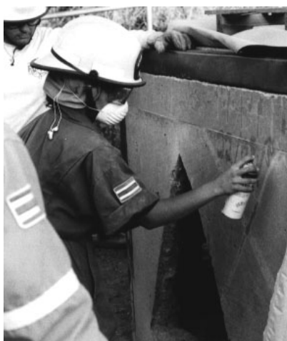
Figura 2. Las marcas deben ser efectuadas bien a la vista y con un color fluorescente que contraste con el lugar donde se marque.
