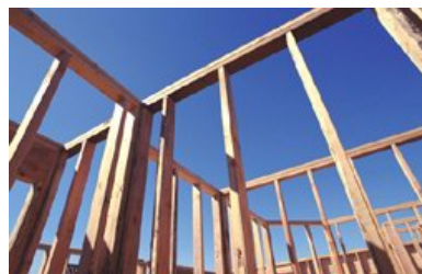
Figura 6. Construcción de madera.
